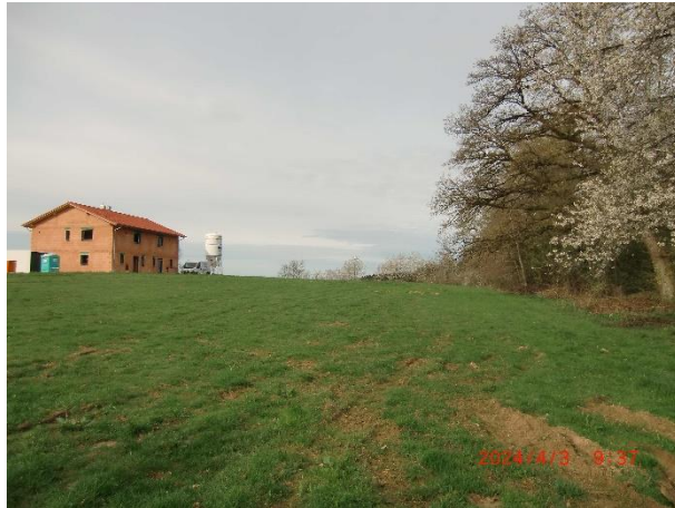
Abbildung 1: Stand Nordost; Blick nach Westen
