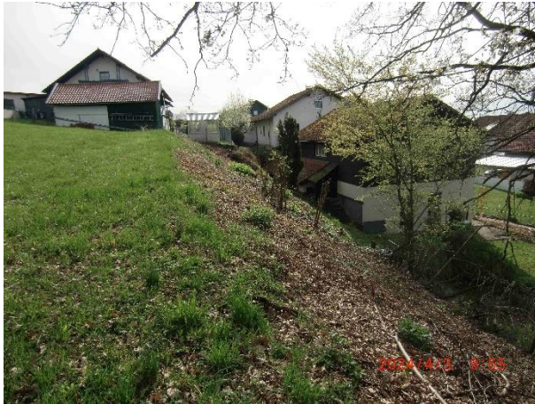
Abbildung 7: angrenzender Böschungsbereich im Süden
