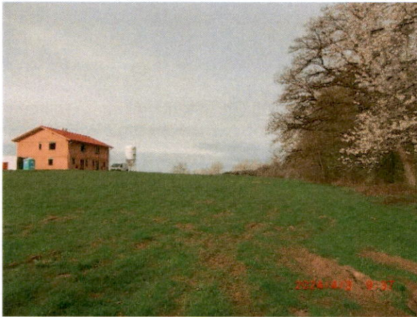
Abbildung 1: Stand Nordost; Blick nach Westen
